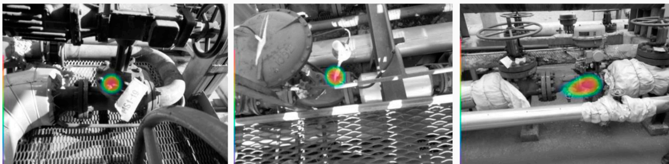
Локализация утечек на нефтеперерабатывающем заводе NL камерой. Утечки подтверждены инфракрасной камерой
