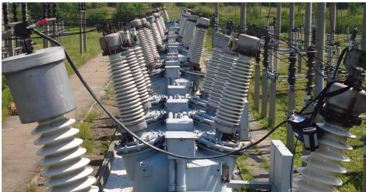
Рисунок 10 - Общий вид установки прибора на полюсе выключателя МКП-110
